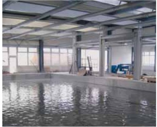
Nicht das Mitarbeiterschwimmbecken des Unternehmens, sondern die Tasse für die neue Anlage beim Test auf Dichtigkeit
