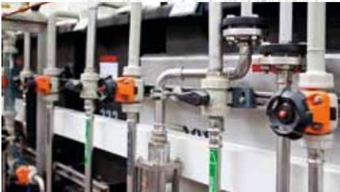
Robust: Rohrleitungen aus V4A-Edelstahl
